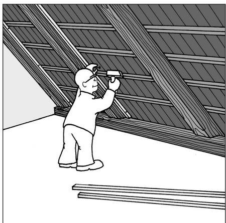
Потім вирізаються пінополістиролові плити відповідної ширини та втискаються між стропильними ногами. Рекомендується укладати пінополістиролову ізоляцію в два, взаємно зміщені шари.
